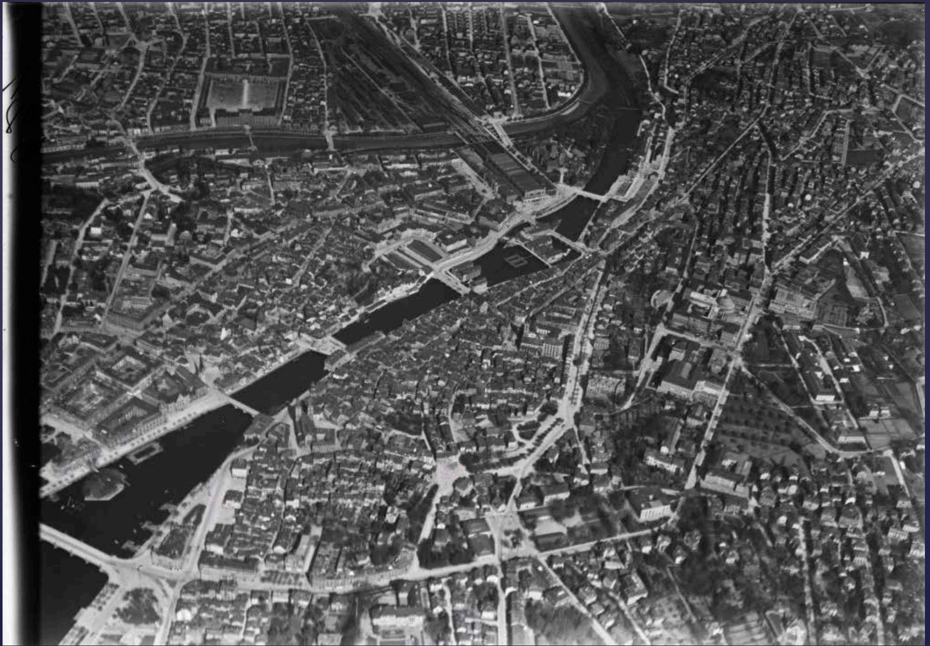
{ Zürich, Übersicht, Altstadt, Hauptbahnhof, 1919
